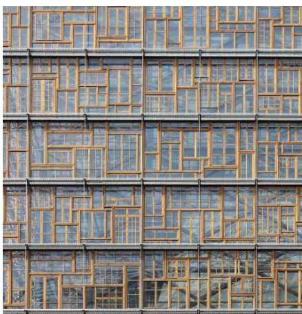
Gevel van gerecycleerde raamkozijnen, zetel van de Raad van de Europese Unie
