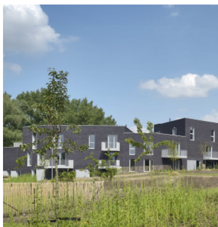
41 nieuwe energiezuinige woningen ontwikkeld door de Grondregie van de Stad Brussel, Harenberg III (2022)
