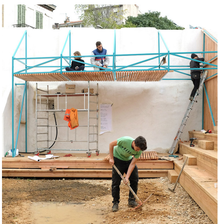
Collectif Etc, aanleg van een sportveld in de wijk Belle de Mai, in Marseille.
