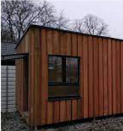
Nieuwe modulaire woningen voor daklozen in Neder-Over-Heembeek
