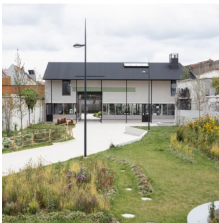
Standaardsite Gent: afbraak van een grote winkel en de bijbehorende magazijnen om een groene ruimte te creëren die toegankelijk is voor bewoners en een multifunctionele gemeenschapsruimte
