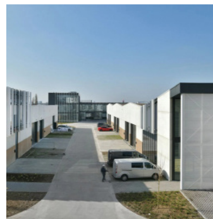
Nieuwe ateliers op de site NorthCity, aan te vullen met een huisvestingsprogramma
