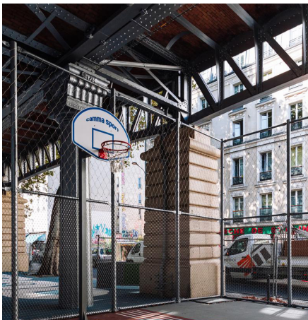
Basketvelden aangelegd onder de bovengrondse metro, Parijs
