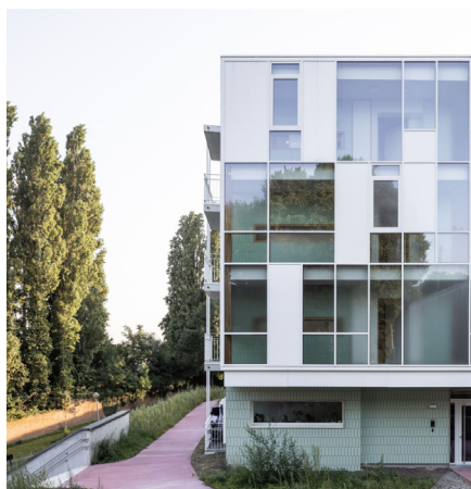
42 nieuwe woningen voor senioren (60+) en een polyvalente zaal in de Ransbeekstraat 58, Neder-Over-Heembeek, LAVA Architecten
