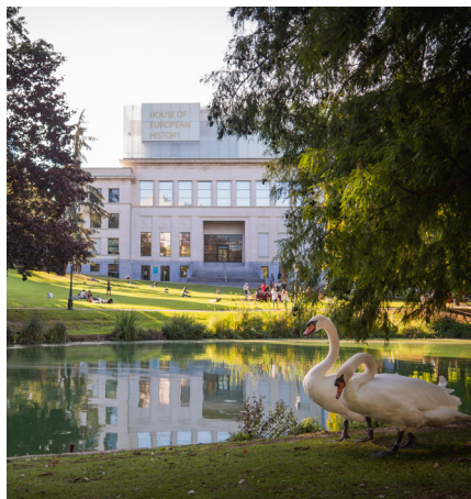
Zicht op het "House of European History" vanuit het Leopoldpark.
