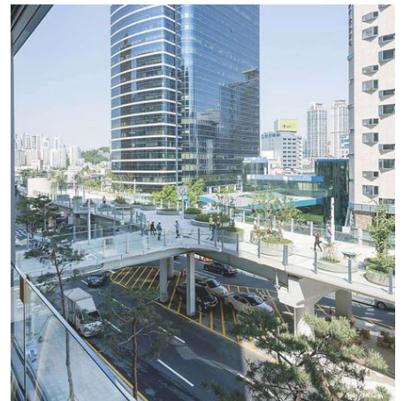
Transformatie van een snelwegviaduct in een voetpad met planten, Seoul, MVRDV
