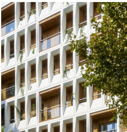
Verbouwing van een kantoorgebouw tot woningen - Charenton-Le-Pont, door het bureau Moetti-Rivière
