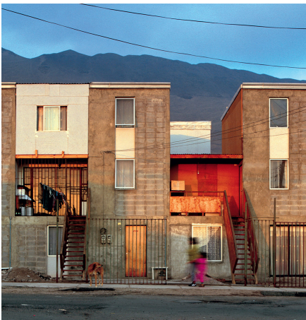
Sociale huisvesting aangepast aan de behoeften van de bewoners door zelfbouw - Alejandro Aravena
